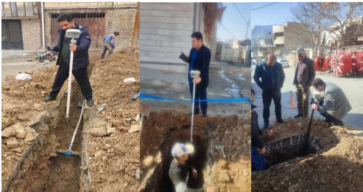
شکل ۴. برداشت نصب انشعابات آب به صورت روزانه و توسط دستگاه GPS سه فرکانسه به منظور انتقال به سامانه
