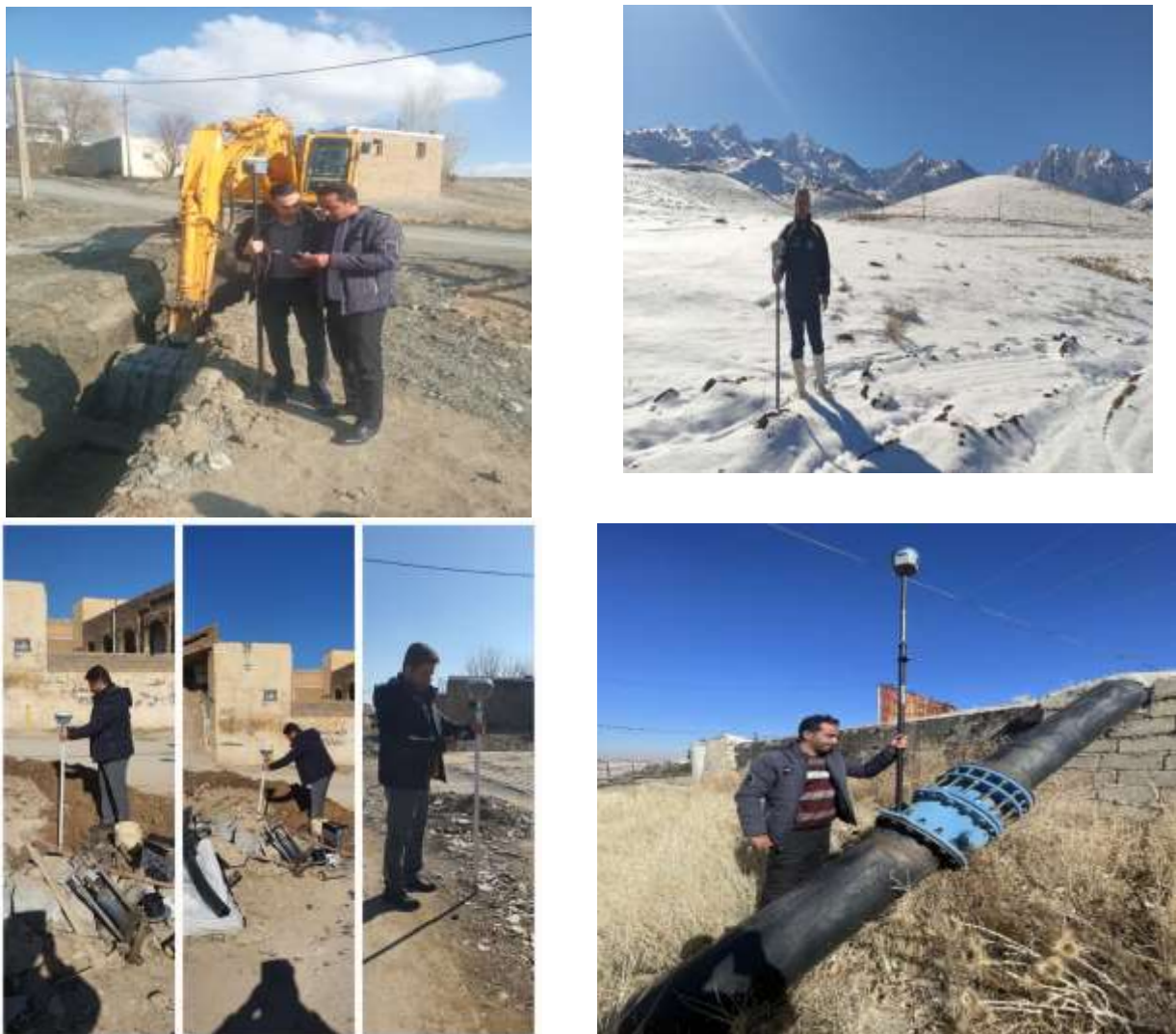
شکل ۷. برداشت اطلاعات حوادث شبکه و خطوط انتقال و شیرآلات شبکه جهت ثبت در سامانه GIS
