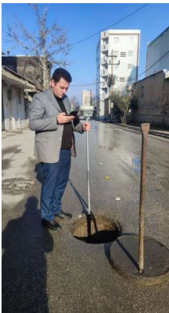
شکل ۶. برداشت دارایی‌های شرکت (حوضچه‌ها و منهول‌ها) توسط دستگاه GPS سه فرکانسه به منظور انتقال به سامانه
